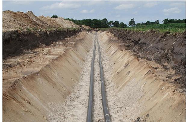
Abb. 11: Erdkabel einer Hochspannungs-Gleichstrom-Übertragungsleitung (HGÜ) – ein Kabel mit positiver Polarität und ein Kabel mit negativer Polarität
