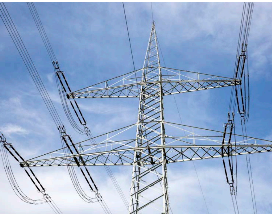
Zwischen Osterath und Rommerskirchen müssen für die Gleichstromübertragung größtenteils nur die Isolatoren eines Stromkreises getauscht werden.
