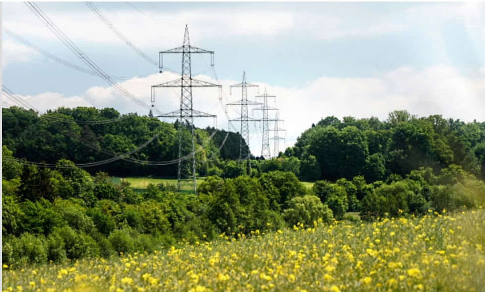
Blick entlang der Ultrahochspannungs-Trasse in Hessen
